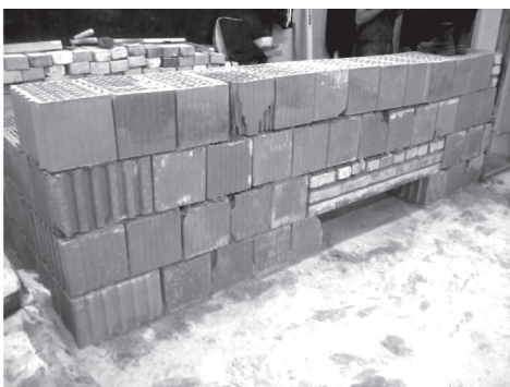
1. kép. Tanulói műhelymunka: egy-egy kivitelezési részfeladat megoldása – kerítéslábazat építése és áthidaló elhelyezése (a képeket Erdősi Zoltán magasépítőtechnikus-jelölt készítette)
