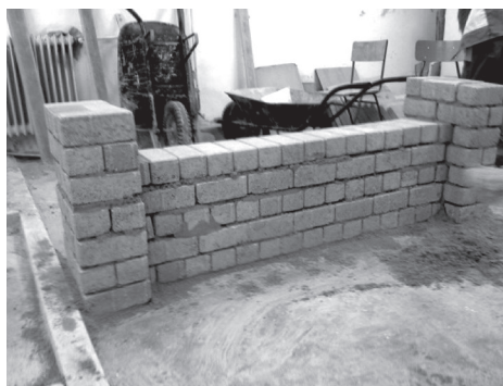
1. kép. Tanulói műhelymunka: egy-egy kivitelezési részfeladat megoldása – kerítéslábazat építése és áthidaló elhelyezése (a képeket Erdősi Zoltán magasépítőtechnikus-jelölt készítette)
