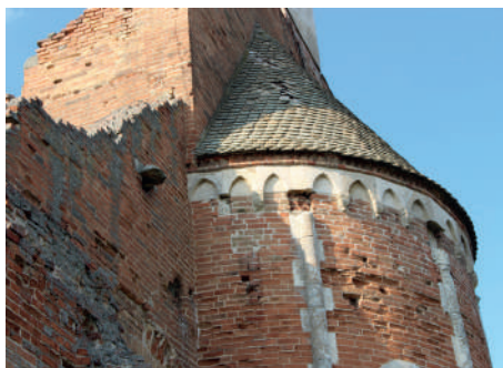
9. A főapszis 1970-es években rekonstruált tetőzete és főpárkánya (2017)
