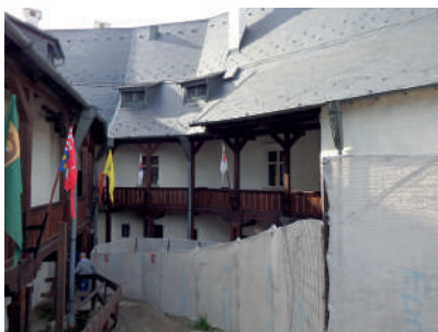
11. Az északnyugati palotaszárny udvari homlokzata 2017-ben (fotó: Simon Zoltán)
