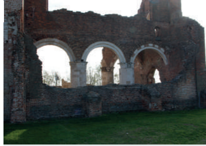
11. A főhajó 1970-es években újjáépített északi fala (2017)
