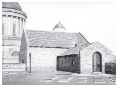
11. A lakótorony vasbeton födéme és az elkészült várkapolna, Építészeti Múzeum, Várnai Archívum
