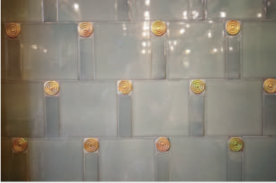
15. Részlet a lábazati sávról (Zeneakadémia, emeleti előcsarnok)
