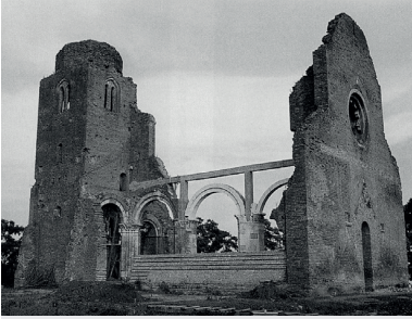
10. Az újjáépülő főhajófal vasbetonbetonváza (1970-es évek)
