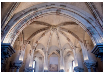
9. A kápolna szentélyboltozata a kiegészített téglafal színének tompításával
