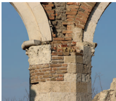
7. A nyolcszögű pillér fejezetsávjának 1898-as helytelen kiegészítése (2017)
