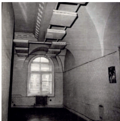
10. Az egykori koncertterem Andrassy-úti frontjának jobb felső sarka, fénykép a Régi Zeneakadémia műemlék rehabilitációja előtti állapotról
