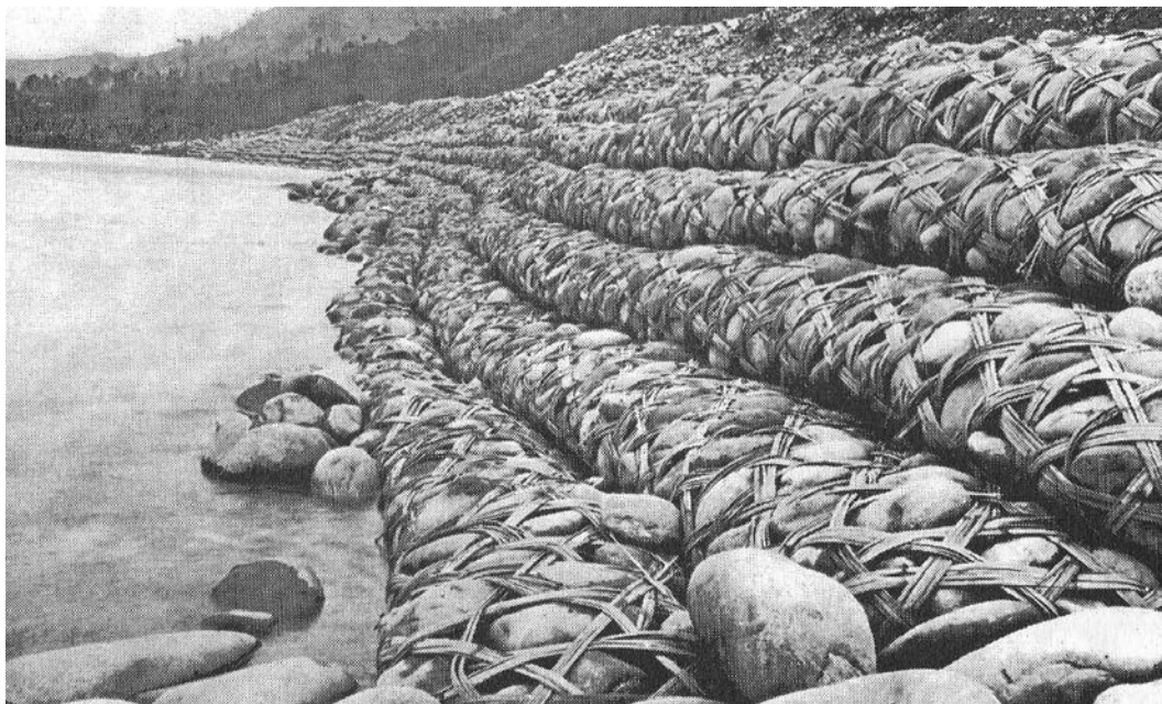
34. ábra A víz okozta erózió ellen triaxiális szövással védik a folyópartot Kínában.
