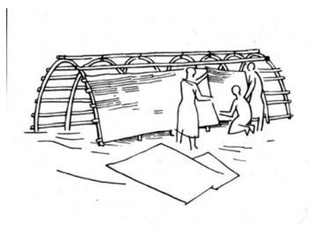
12. ábra Arab nádkunyhó építése.
