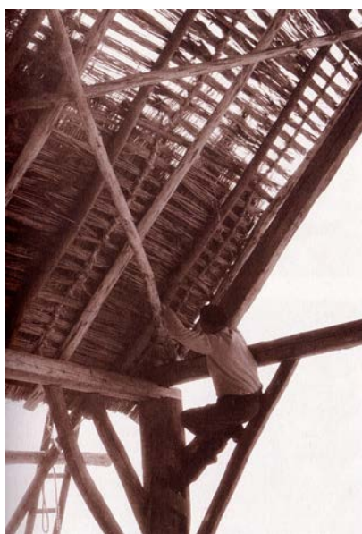
14. ábra Lészás nádtető készítése.
