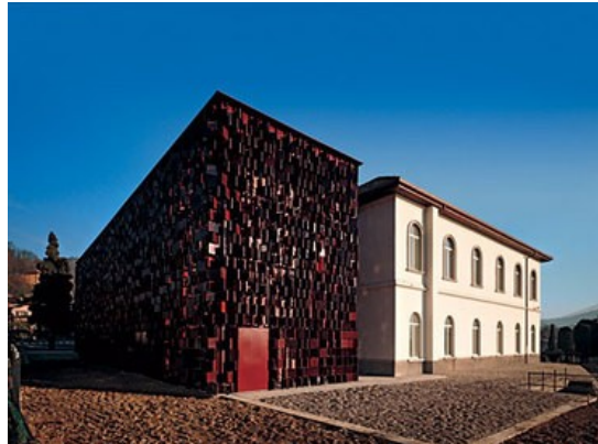
30. ábra A nembrói városi könyvtár homlokzata, valamint a rajta lévő, mozgatható terrakotta lapok részlete.
