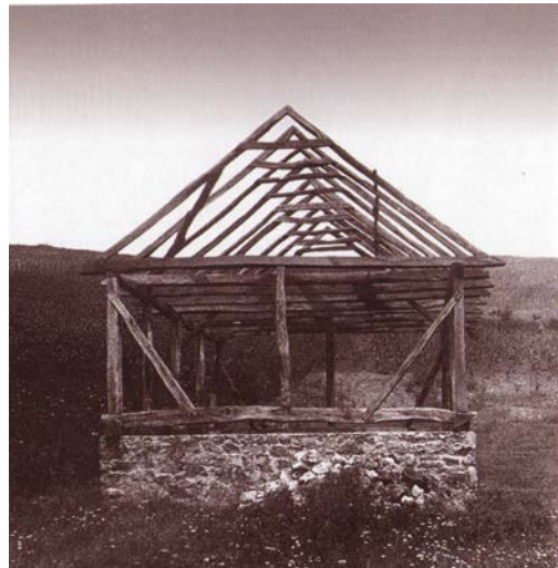
16. ábra Talpas-vázás ház szerkezete.
