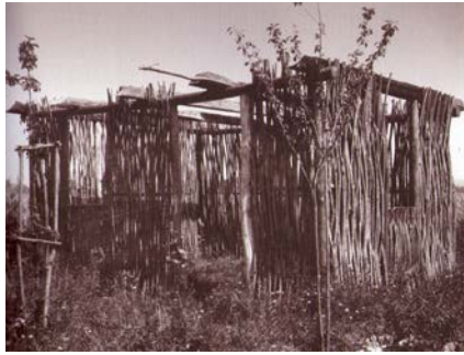
15. ábra Cölöpvázás épület függőlegesen font sövényfallal.
